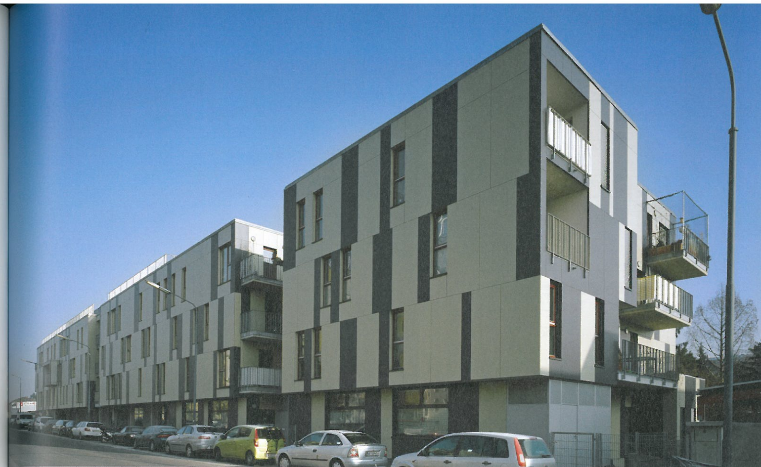
Strassenseitig bleibt der 12 Meter hohe Bau eher verschlossen.
